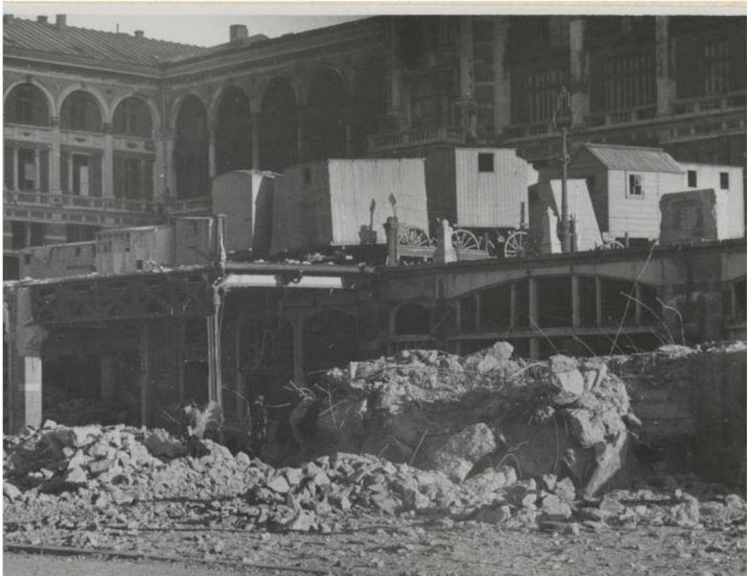
Afbeelding 17. Sloop van de tankmuur voor het Kurhaus (bron: beeldbank Haag Gemeentemuseum).
